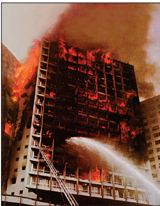
Figura 11: Incêndio no Edifício Andraus
