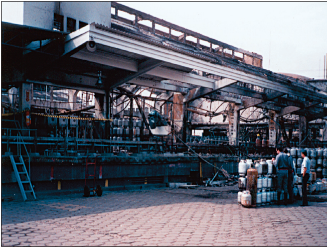
Figura 8: Perícia de incêndio
