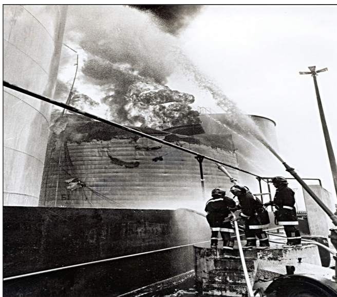
Figura 69: Incêndio em parque de tanques
