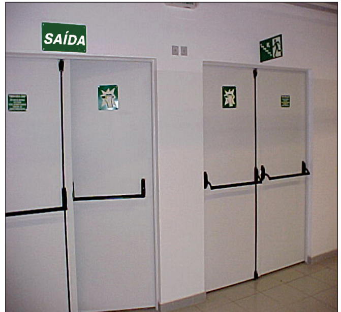
Figura 53: Porta com barra antipânico
