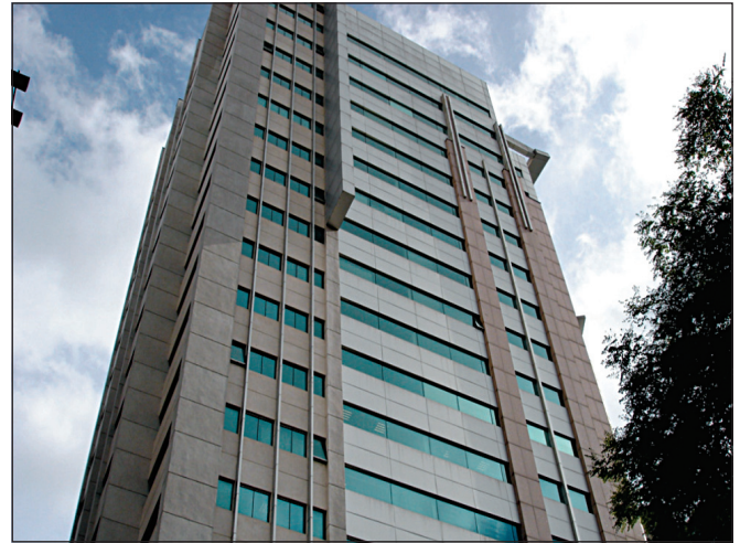
Figura 10: Compartimentação vertical de fachada
