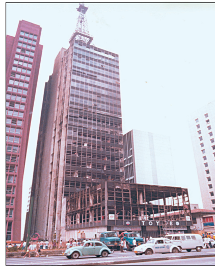
Figura 14: Incêndio no Edifício Grande Avenida
