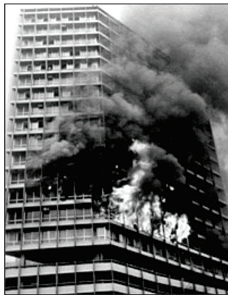
Figura 12: Incêndio no Edifício Joelma
