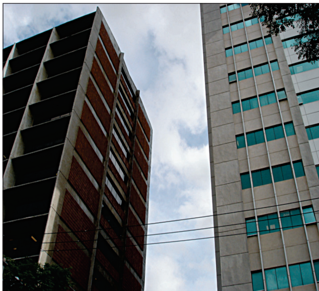
Figura 35: Compartimentação vertical
